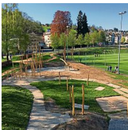
Die Bauarbeiten für den Generationenplatz sind auf Kurs. z.Vg.
