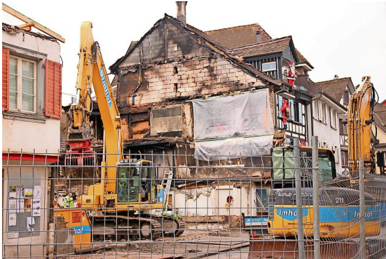
Archivbild: So sah die Altstadt in Steckborn kurz nach dem Feuer aus. Der Schaden betrug zwölf Millionen Franken.
