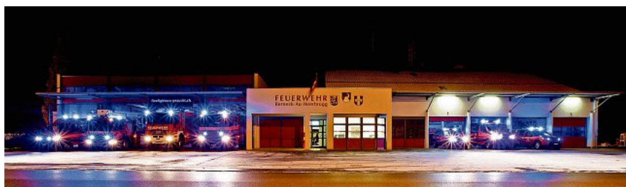
Das Feuerwehrdepot der Feuerwehr Berneck-Au-Heerbrugg.
