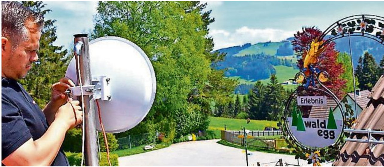
Markus Breitenmoser installiert die Empfangsgeräte für das Internet auf dem Höhenrestaurant Waldegg.
