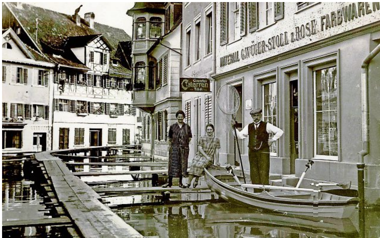
Hochwasser in Steckborn im Jahr 1926.
